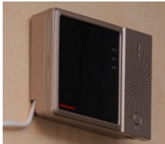
安装燃气泄漏报警器
